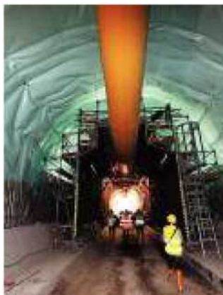
Il tunnel di Chiomonte
