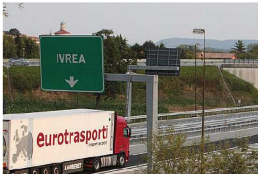
L'autostrada A5 all'altezza dell'uscita di Ivrea
