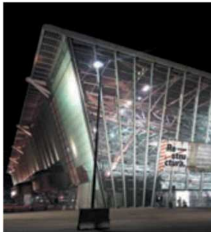
EDIZIONE 2015 Restructura è all'Oval
