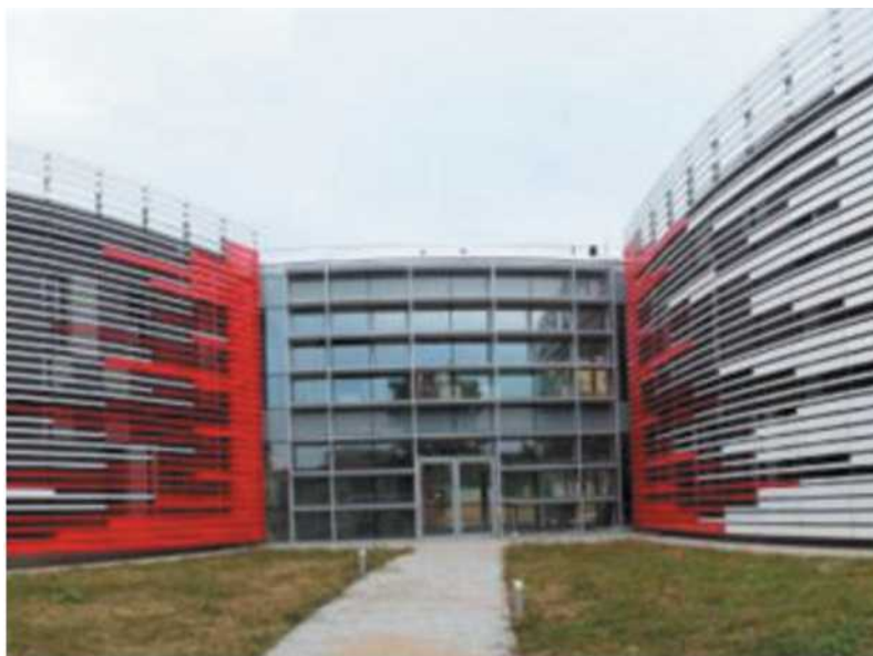
SPAZIO LILT Terminati i lavori del nuovo Centro
