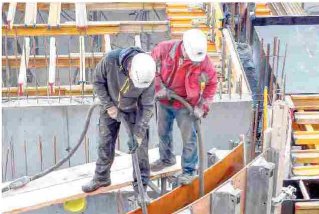
Artigiani al lavoro in un cantiere edile (foto di repertorio)
